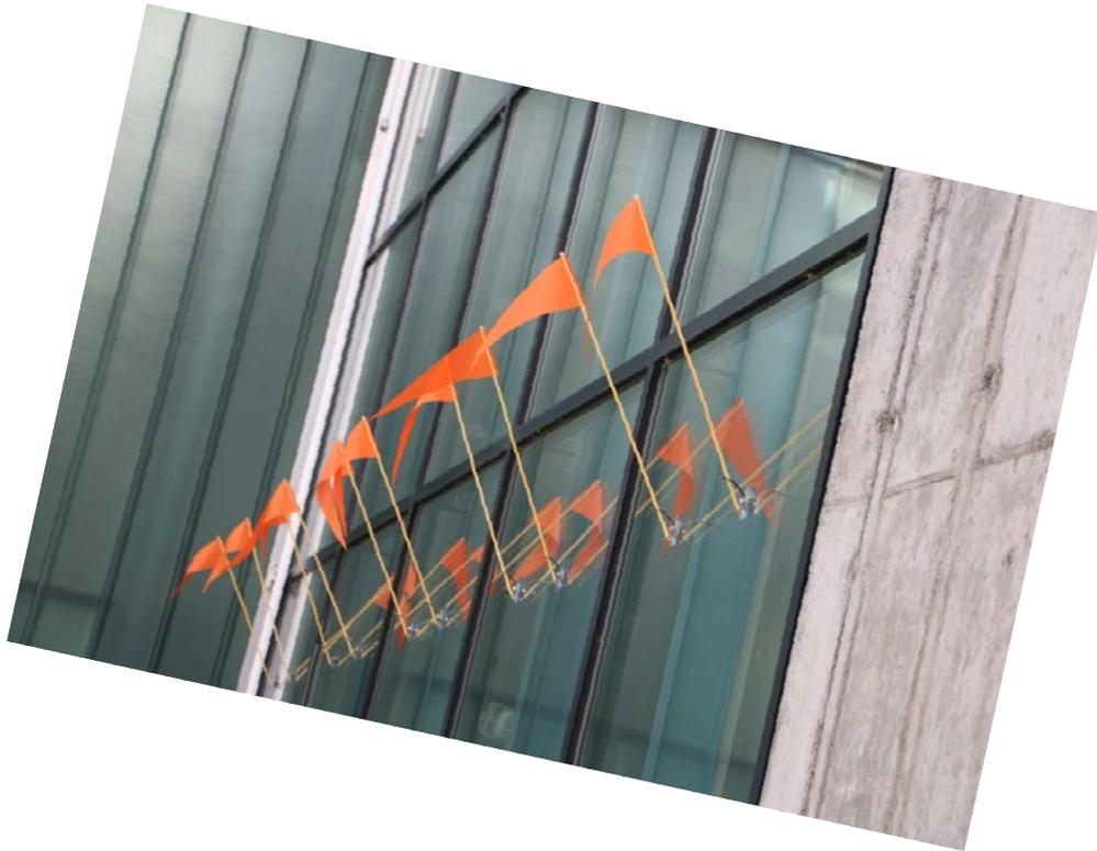
Dies sehen Vögel rechtzeitig und bleiben fern. Zur Reinigung der Glasflächen lässt sich das Fähnchen leicht aus der Halteklammer lösen, ohne dass der Saugnapf abgelöst wird. Sämtliche Anwender bestätigen die schützende Wirkung dieser Konstruktion, die beim DPMA zum Patent angemeldet wurde.
